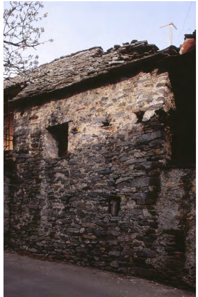
30 Cugnasco, Wohnhauskomplex: Südfassade des Eckhauses während der Bauuntersuchung vor und während des Abbaus. Aufnahme Mai 2000.
