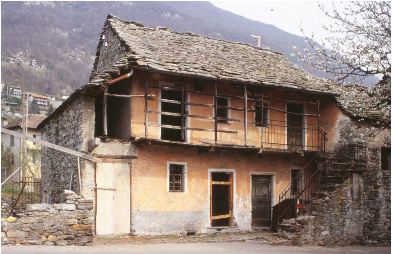
32 Cugnasco, Wohnhauskomplex: Doppelwohnhaus: Fotografie mit Blick auf die Südfassade während der Bauuntersuchung vor und während des Abbaus. Blick nach Norden. Aufnahme Mai 2000.
