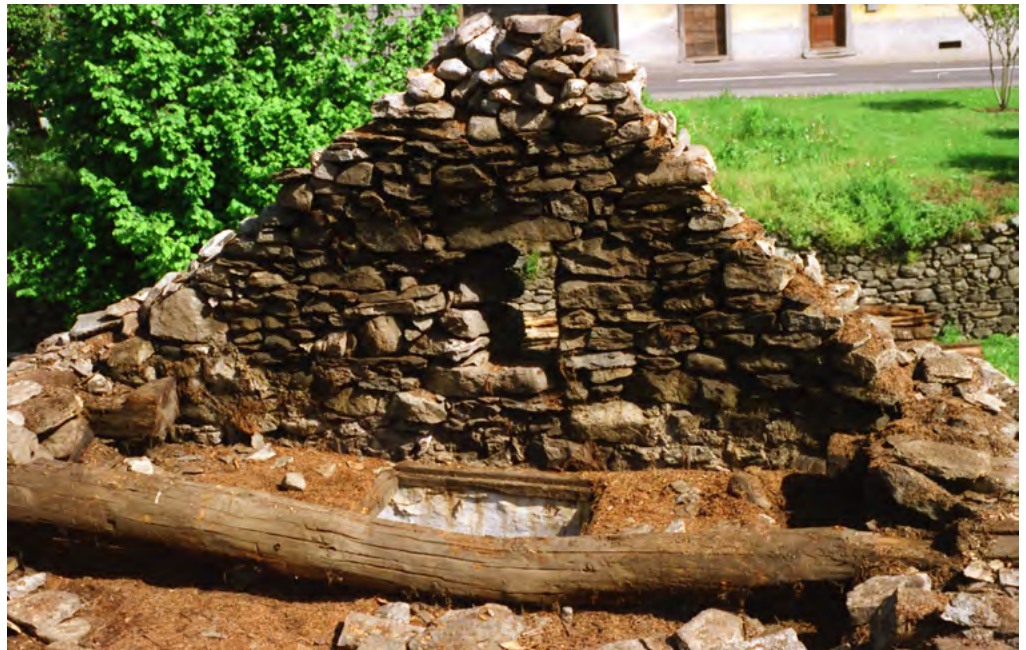
34 Cugnasco, Wohnhauskomplex: Dachstock im Nordhaus während des Abbaus. Das Dachwerk bestand aus Stichbalken und einigen durchlaufenden Ankerbalken. Blick nach Norden. Aufnahme Mai 2000.
