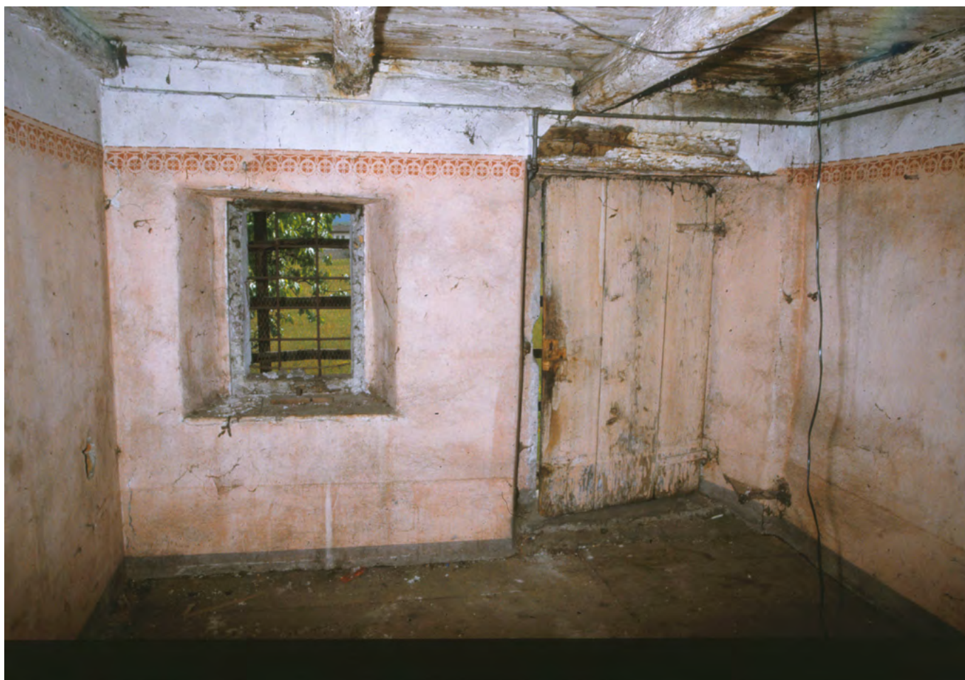
42 Cugnasco, Wohnhauskomplex: Westraum im Obergeschoss des Doppelwohnhauses. Dieser Raum war mit ockerroten Wandpartien und einer Zierborte ausgestaltet worden. Blick nach Süden. Aufnahme Mai 2000.
