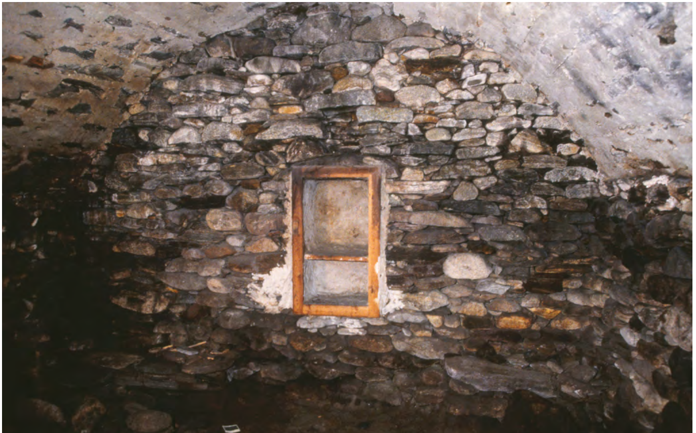
43 Cugnasco, Wohnhauskomplex: Die Ostwand des Kellers im Doppelwohnhaus. Blick nach Osten. Aufnahme Mai 2000.
