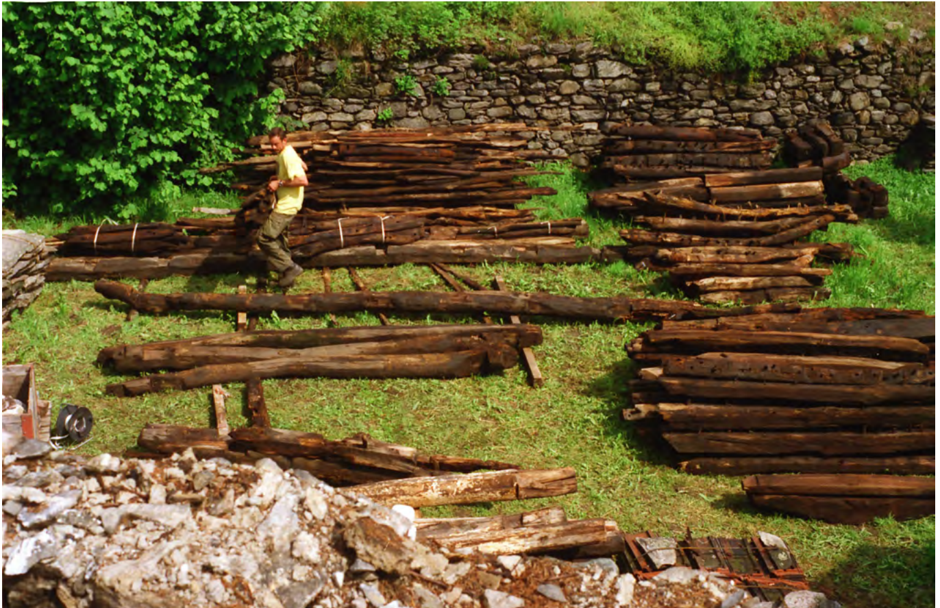
46 Cugnasco, Wohnhauskomplex: Abbauarbeiten im Mai 2000. Sauber gestapelt und sortiert wurde das Holz des Dachwerks zum Transport ins Museum bereitgestellt. Aufnahme 2000.
