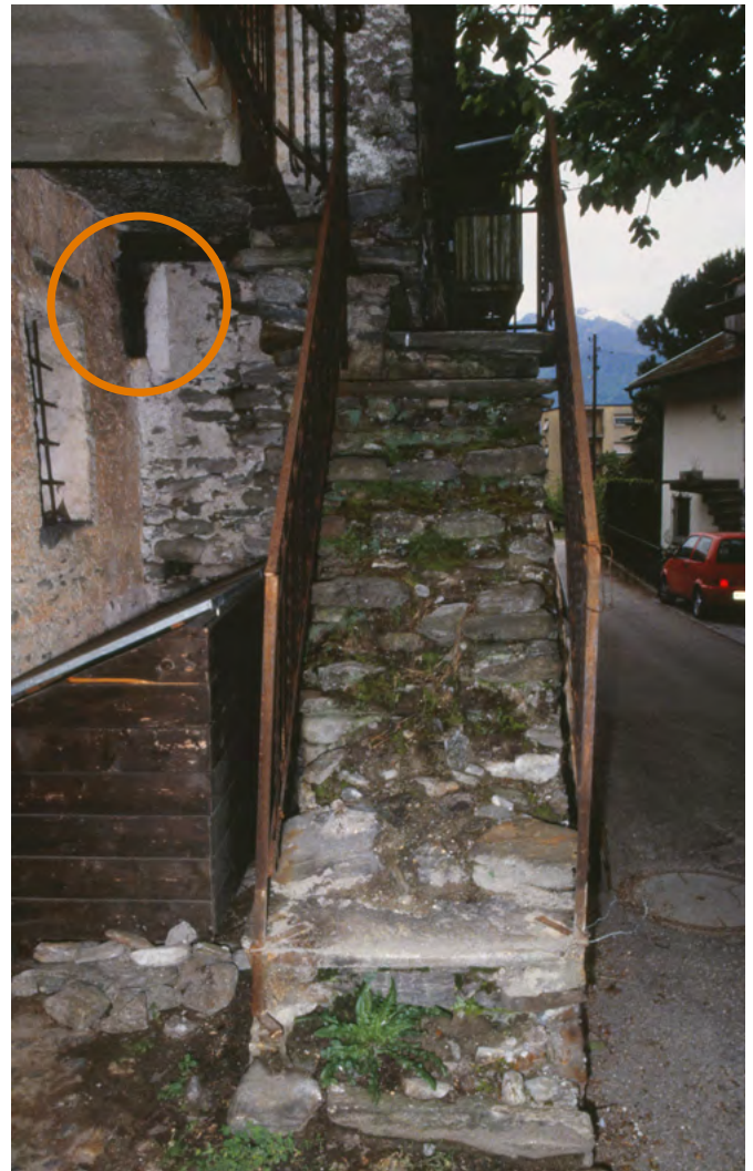
44 Cugnasco, Wohnhauskomplex: Treppe zur südseitigen Laube des Doppelhauses. Im Hintergrund ist die Westfassade des Eckhauses zu erkennen. Sie weist eine weiss umrahmte, halb zugemauerte Fensteröffnung im Obergeschoss auf. Blick nach Osten. Aufnahme Mai 2000.
