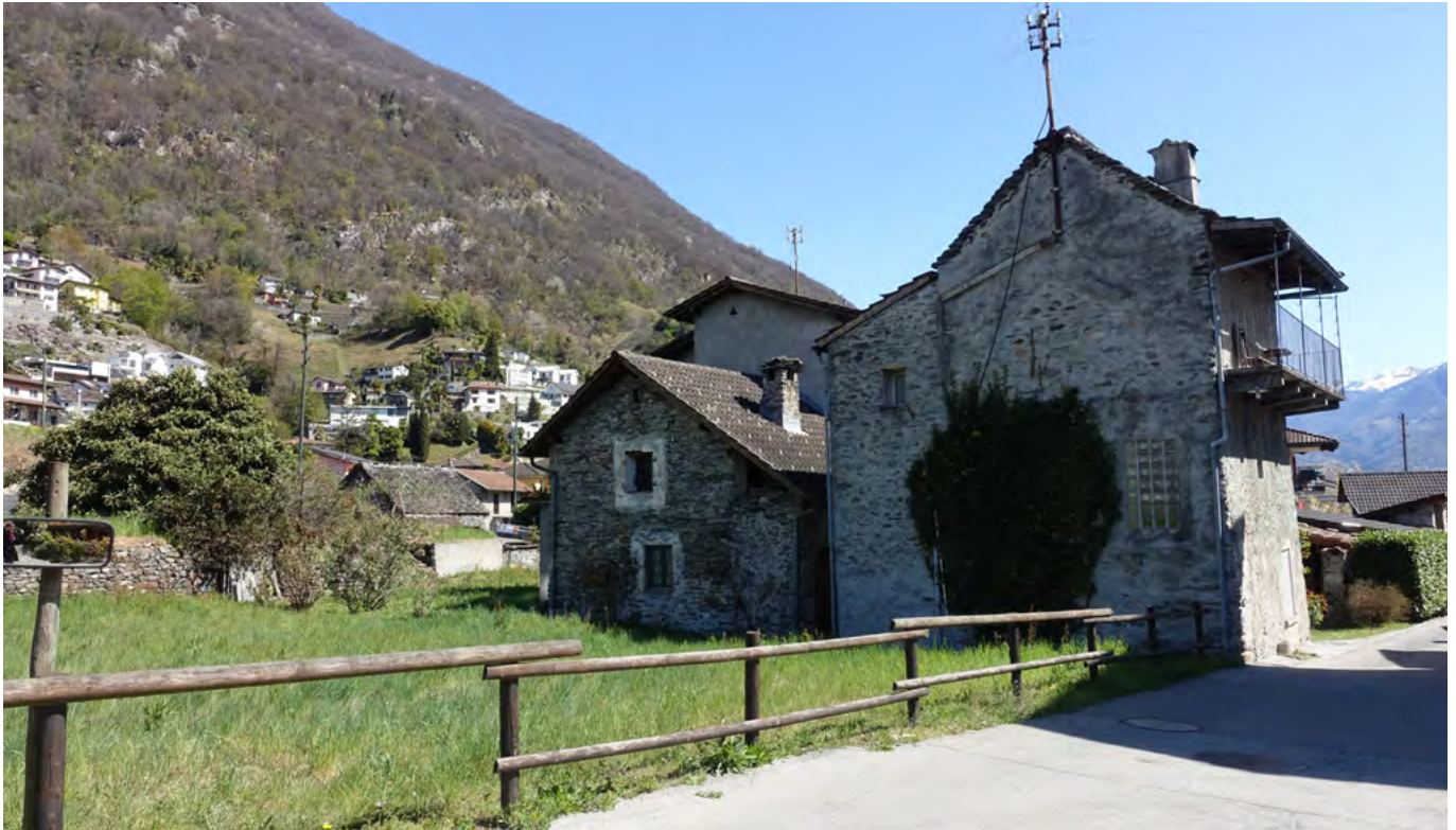
10 Cugnasco, Nachbarbauten des abgetragenen Wohnkomplexes: Am einstigen Standort wächst heute nur noch Gras. Die Nachbarhäuser wurden seit dem 19. Jahrhundert umgebaut und zum Teil abgebrochen. Erhalten haben sich Teile der Häuser mit den Katasternummern 1655, vorne und 1653, hinten. Blick nach Nordosten. Aufnahme 2021.
