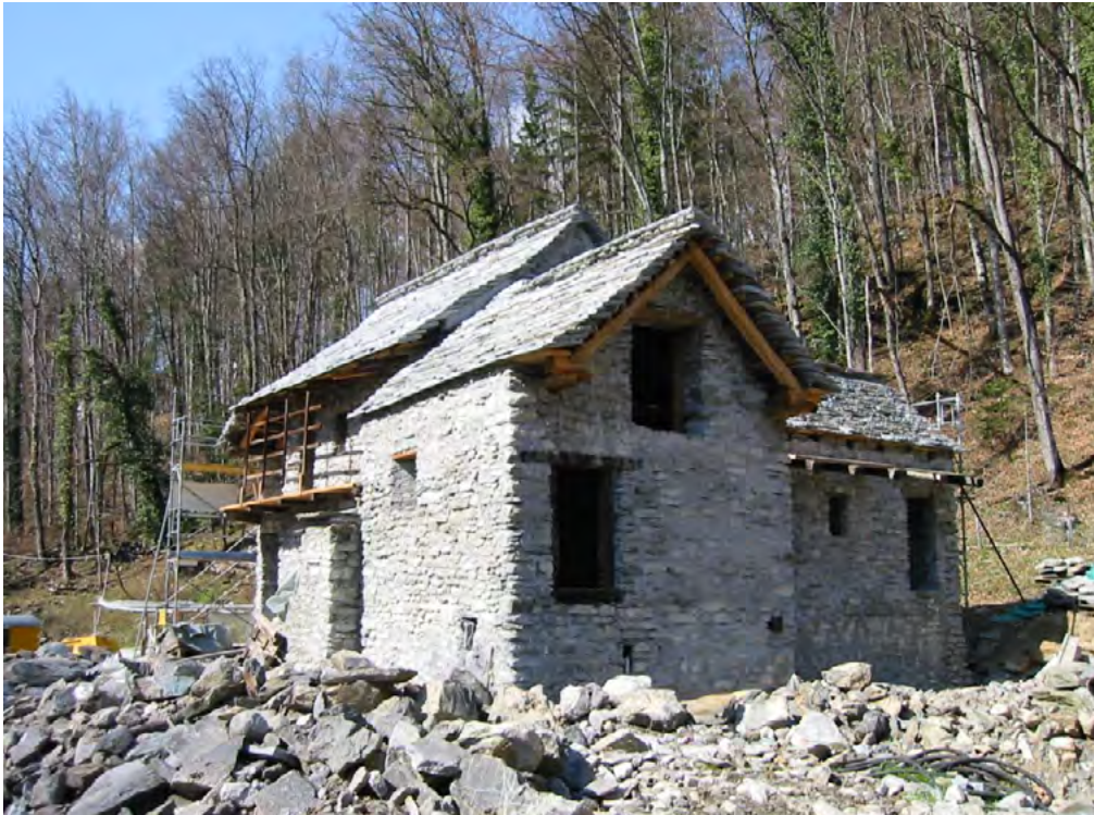
47 Freilichtmuseum der Schweiz, Hauskomplex aus Cugnasco: Der Hauskomplex während des Wiederaufbaus im Museum. Blick nach Westen. Aufnahme März 2002.
