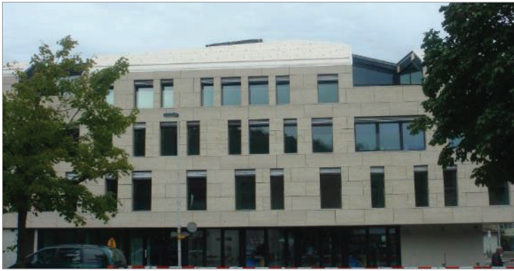
Abb. 3 Hybridbau mit Holzaussenwandelementen (Minergie-P): Fassade aus Jura-Kalk-Platten ( d = 40 \text{ mm} ; Gewicht: 120 \text{ kg/m}^2 ); Raiffeisenbank Bad Zurzach; Metron Architekten.
