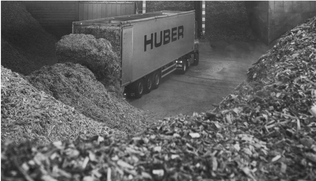
Hackschnitzel im Heizkraft- werk der Axpo Tegra AG in Domat/Ems er- setzen fossile Energieträger. (Bild: Jesco Tscholitsch)
