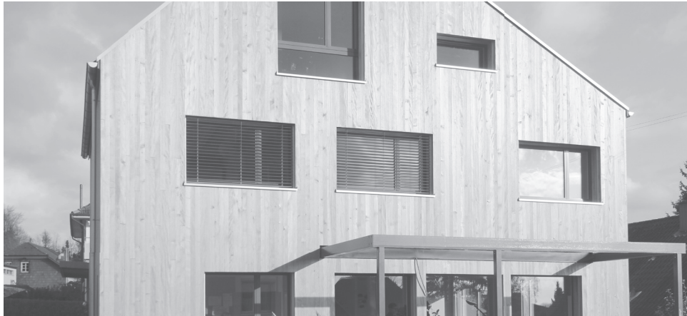
Die Fassade dieses Einfamilienhauses in Bellach besteht aus vorvergrautem Holz (Biood, Schilliger Holz AG Küsnacht) (Bild: David Coulin)
