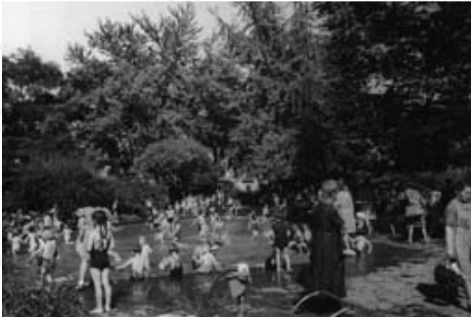
Figur 4.9: Das Wasserbecken der Bäckereianlage im Jahr 1938
