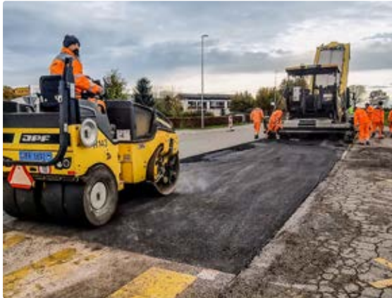
Figure 2 : Construction d'une planche d'essai.
