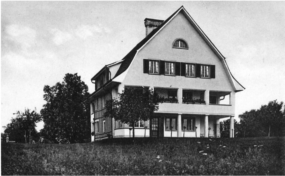
Abb. 26: Die «Fluh», Werner Reinharts Haus in Maur am Greifensee, Kanton Zürich (Hermann-Burte-Archiv, Maulburg).
