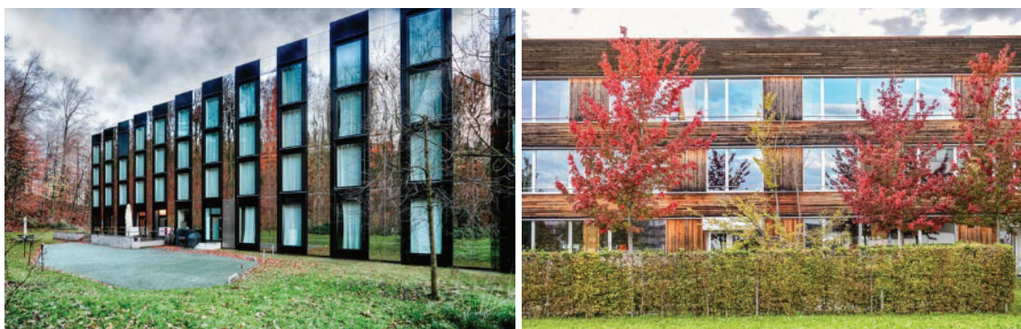
Abb. Wie muss gebaut werden, dass der heutige Holzbau ebenso identitätsstiftend wird? Zwei Holzbauten aus dem Jahr 2009: City Garden Hotel, Zug (Foto Joshua Schifferle Alva) – Schulhaus Eichmatt, Hünenberg (Foto Remo Schnüriger)
