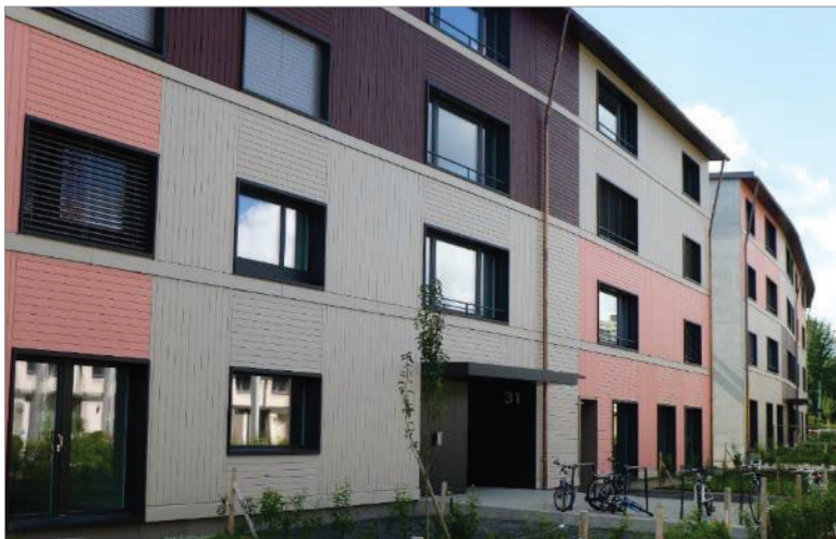
Abb. 8 Holzfassade mit Oberflächenbehandlung (komplette Applizierung im Werk) Überbauung Grünmatt, Zürich; Graber Pulver Architekten AG; Zürich
