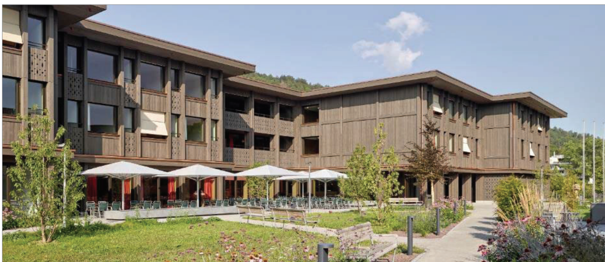
Abb. 1 Möbelstück Gebäude: Hybridbau mit Aussenwandelementen und Fassade in Holz Generationenhaus Bad Zurzach: Liechti Graf Zumsteg Architekten, Brugg; (Bildquelle)(Behandlung: Kesseldruckimprägniert mit Farbton braun; 2 x Lasur impra®lan)
