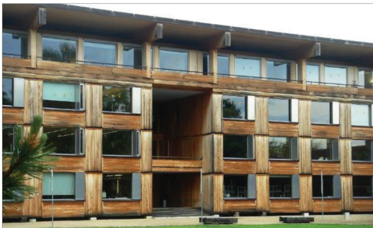
Abb. 5 Trotz grossem Vordach ist die Holzfassade in Eiche nicht vor Witterung, insbesondere Schlagregen, geschützt; Lehrgebäude Berner Fachhochschule Biel; Meili, Peter & Partner Architekten, Zürich
