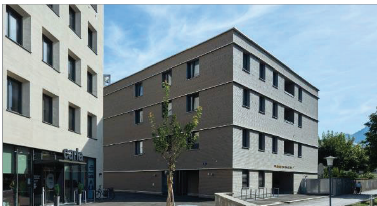
Abb. 6 Gebäude mit kleinem Vordach aber mit Schutzmassnahmen in der Fassade (in Kombination mit den Brandschutzmassnahmen pro Geschoss) Katholisches Kompetenzzentrum Süd, Salzburg; Hermann Kaufmann + Partner ZT GmbH, Schwarzach (A); (Bildquelle)
