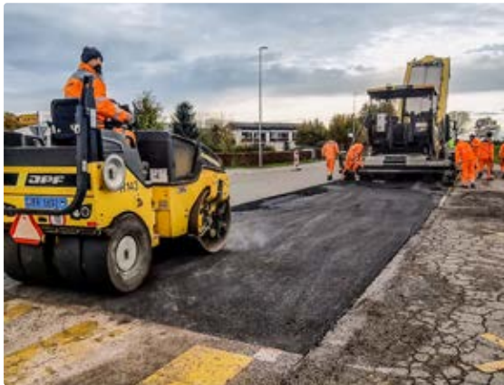
Figure 2 : Construction d'une planche d'essai.
