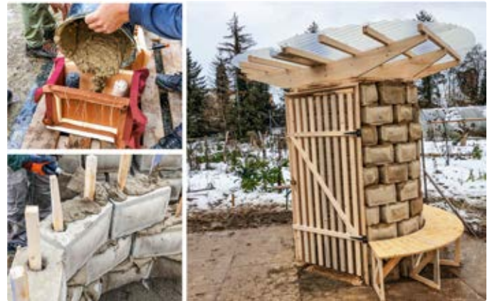
Abbildung 3: Im Herbst 2022 wurde ein weiterer, runder Pavillon errichtet.
