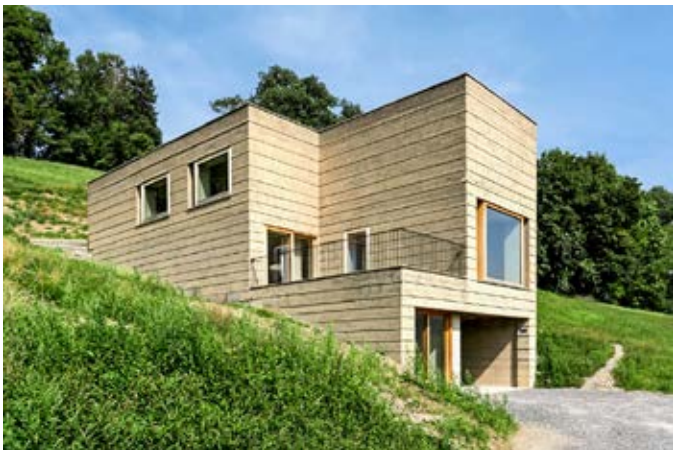
Abbildung 1: Das Haus aus Stampflehm von Martin Rauch in Schlins (AT), das sich durch den mutigen Verzicht auf grosse Dachvorsprünge auszeichnet
