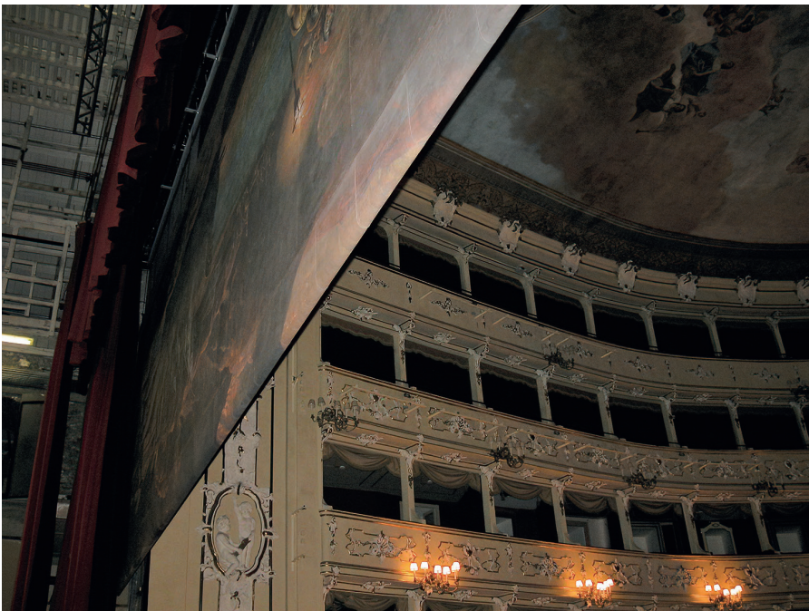
Fig. 22. Il sipario del teatro Sociale di Como in fase di sollevamento: in alto si intravede lo spazio di alloggiamento sopra la graticcia
