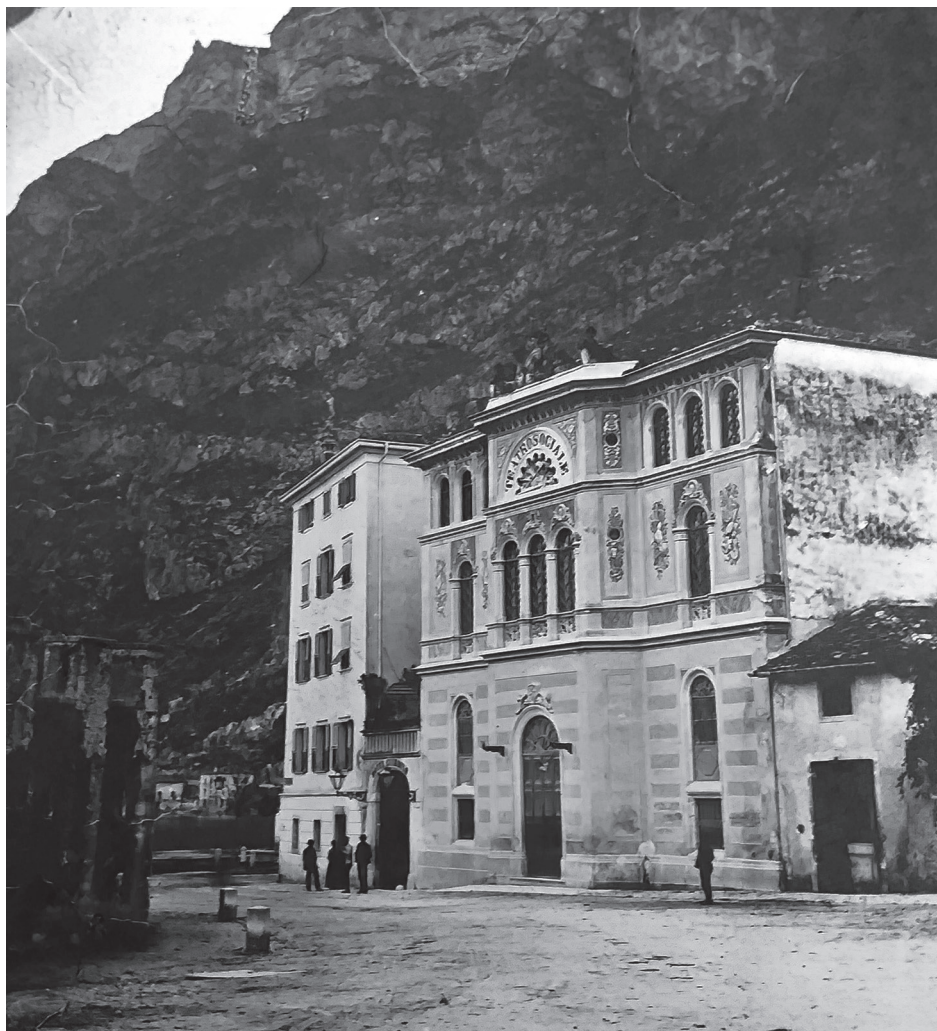
Fig. 1. Facciata del Teatro Sociale di Riva, 1878; ASCR
