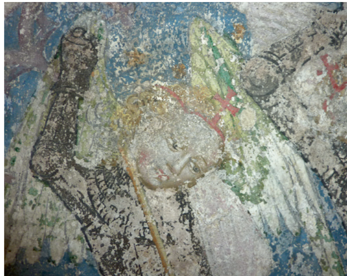
▲ Wandmalerei im Münster Konstanz: Neben dem Ausbleichen führt auch der Substanzverlust zu einer Reduktion der ursprünglichen Wirkung. Bei Wandmalereien sind oft nur noch die Vorzeichnungen und Untermalungen erhalten. Trotzdem sind sie für uns lesbar und ein wichtiges Zeugnis.
