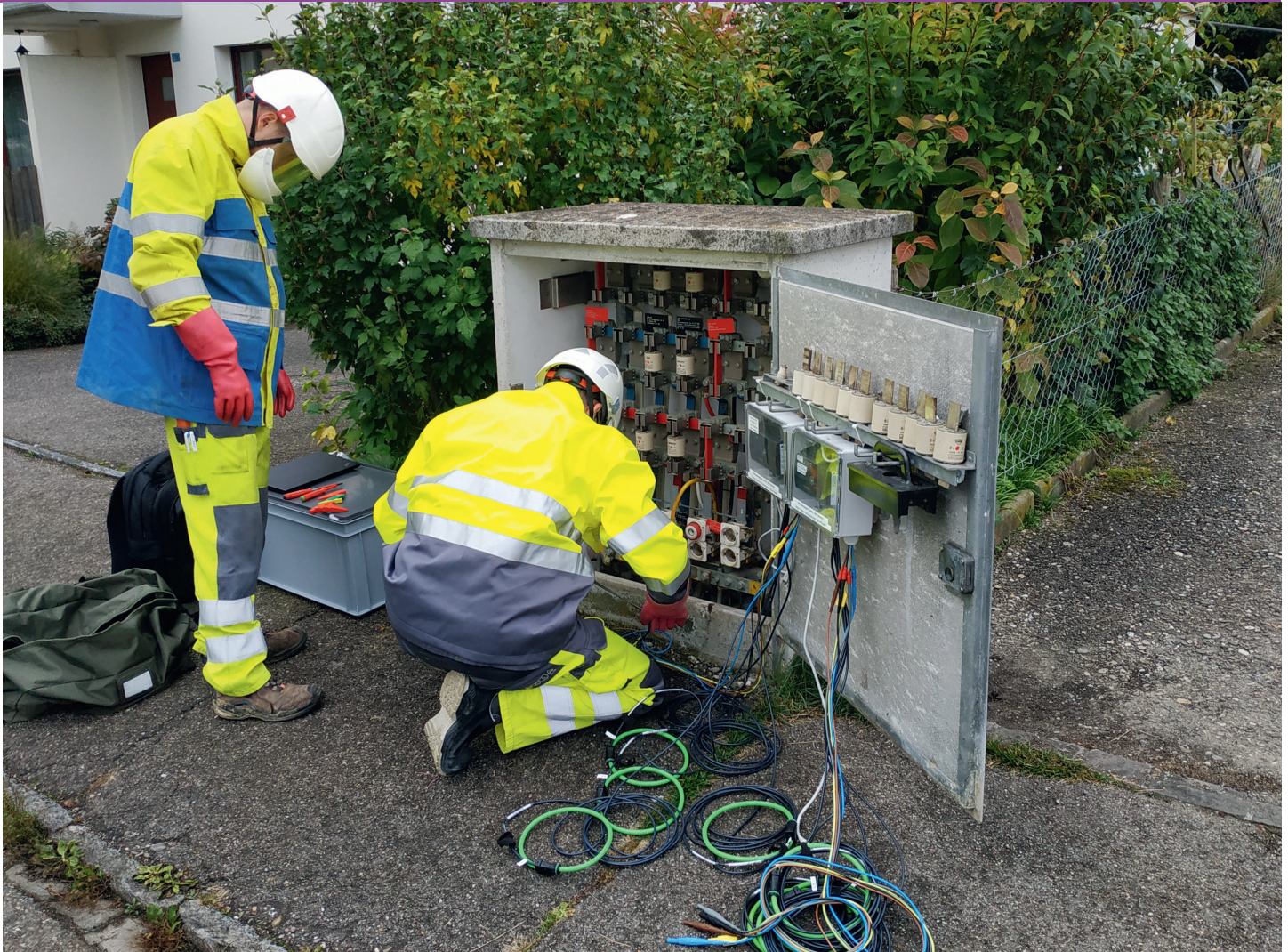
Installation der PQ-Messgeräte in einer Verteilkabine.
