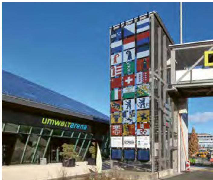
Bild 9.1: Kantonswappen produzieren Strom – kristalline PV-Module, die mit einem Digitaldruckverfahren eingefärbt wurden. (Quelle: Stiftung Umweltarena Schweiz)
