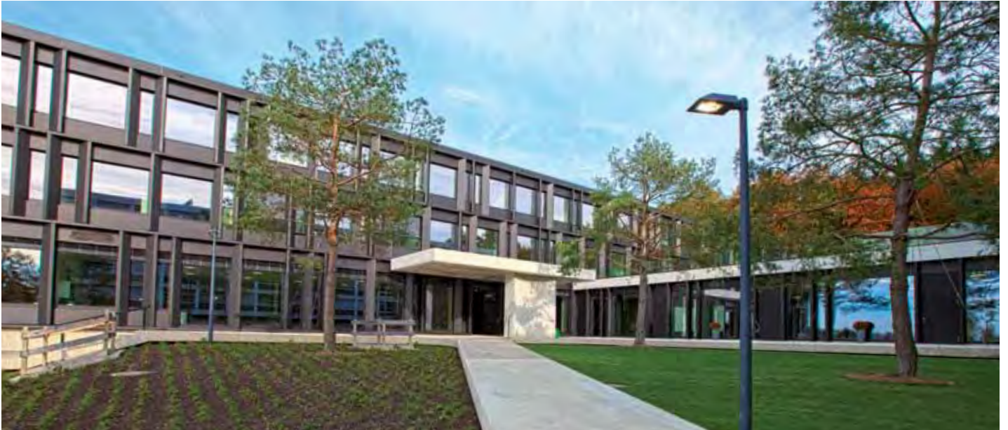
→ Erweiterungsbau mit Innenhof und Zwischentrakt | Vue du bâtiment et du nouveau « Zwischen » (salle de séjour) à partir de la cour d'entrée
