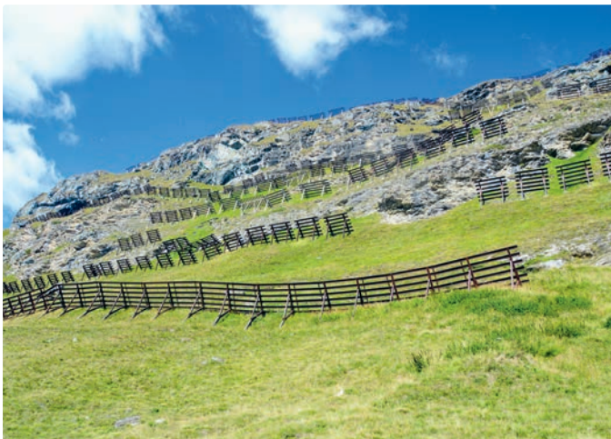
Abb. 1: Stahlschneebrücken in einem Lawinenanbruchgebiet
